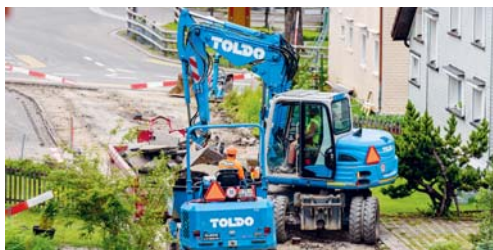
Die Sanierungsarbeiten an der Stickerstrasse sind in vollem Gange.
