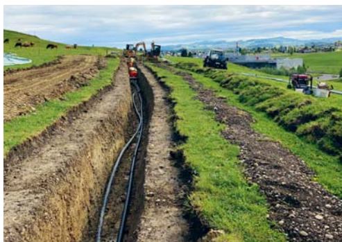
Verlegung der Druckleitung.
