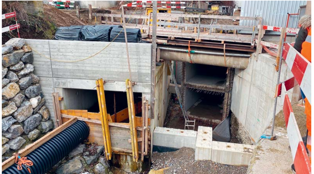
Die Umsetzung des Wasserbauprojekts «Entwässerungssystem/Doppelstockkanal Töbeli»: Links das Goldbach-Portal, das auf einer Länge von 50 Metern erneuert wurde. Rechts der Doppelstockkanal: oben der Dorfbach, unten das Schmutzwasser.
