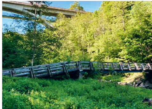
Der Divisionssteg zwischen Flawil und Gossau wird ab dem 13. April 2026 erneuert.
