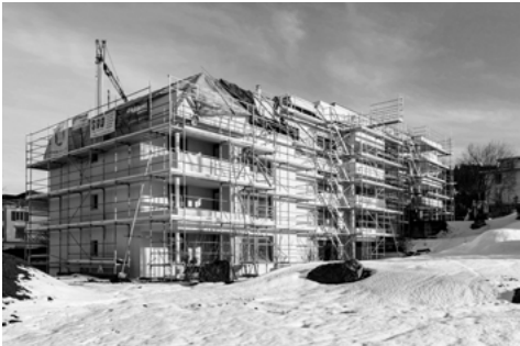
Sanierung MFH Seeblickstrasse
