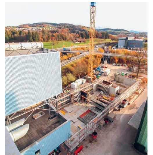
Der Bau der Tiefgarage für die Sammelfahrzeugflotte verläuft nach Plan.
