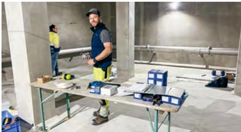
Mitarbeitende der TBF aus der Abteilung Gas/Wasser bei der Montage der neuen Rohre im Reservoir Magdenau.
