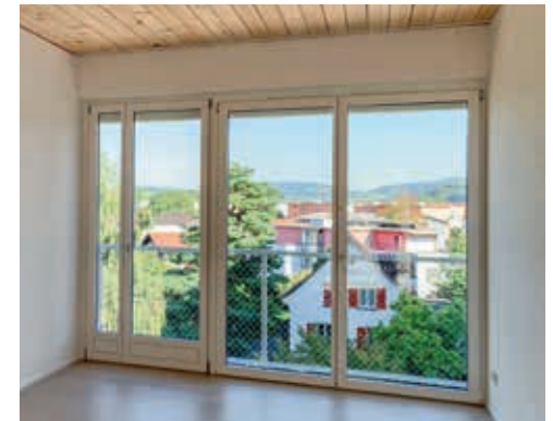
Eine wiederverwendete und eine neue Balkontüre kombiniert – welche ist welche?
