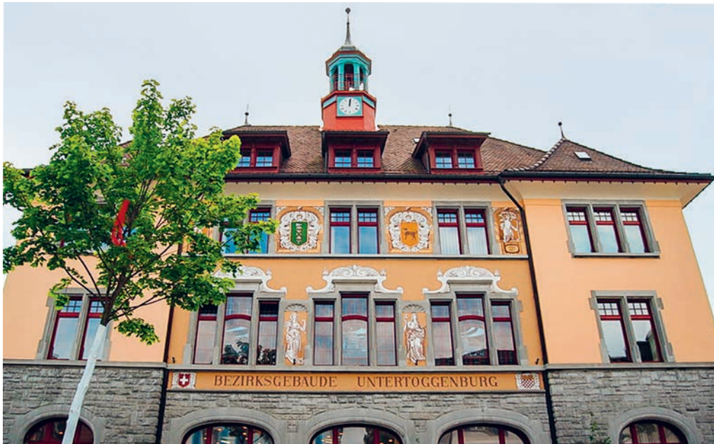
Das Dach und die Fassaden des Bezirksgebäudes werden saniert.
