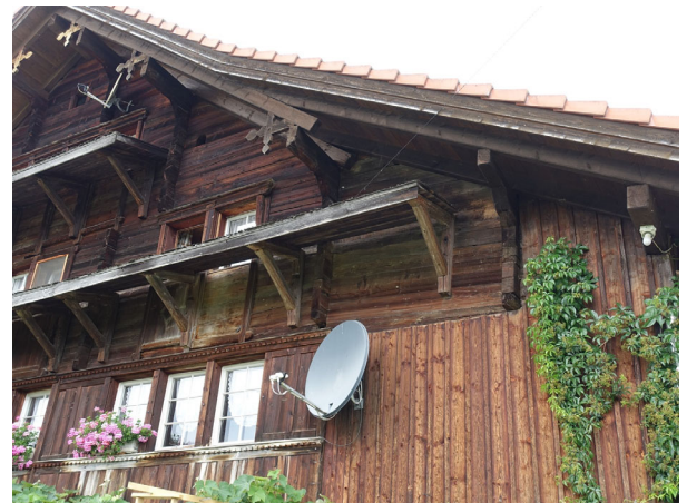
Fassadenübergang Hauptfassade - Anbau
