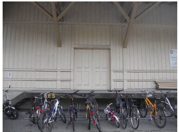
Fassadenstruktur mit Horizontalverstärkung im unteren Bereich
