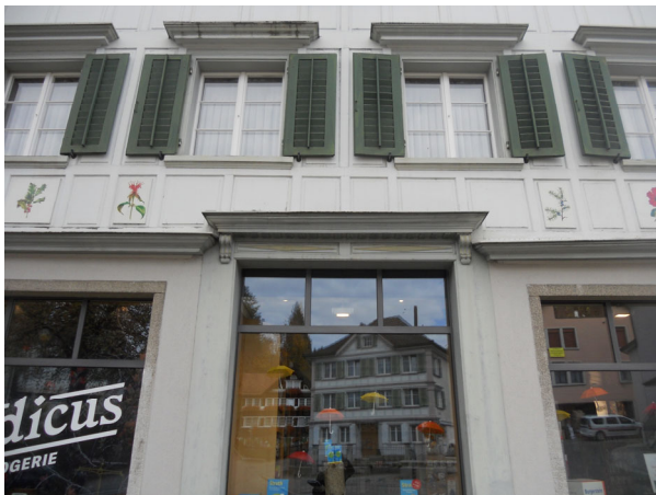
Versatz Gurtgesims über ehemaligem Gebäudezugang
