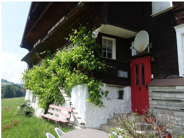
Eingang und Sockelgestaltung an der Hauptfront
