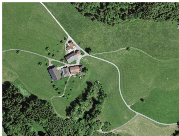
Anordnung der Bauten (Orthophoto geoportal, 2019)
