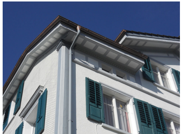
Dachuntersicht mit Eckpilaster
