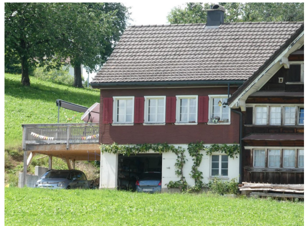
Carportanbau mit Terrasse westseitig
