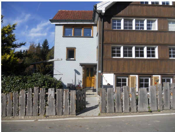
Anbau mit Hauszugang; Verbundsteinpflasterung und Zaun
