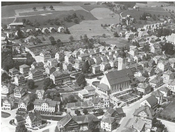
Historische Aufnahme: Bauernhaus Mitte unterer Bildrand
