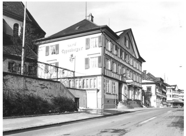
Aufnahme vor der Renovation von 1976
