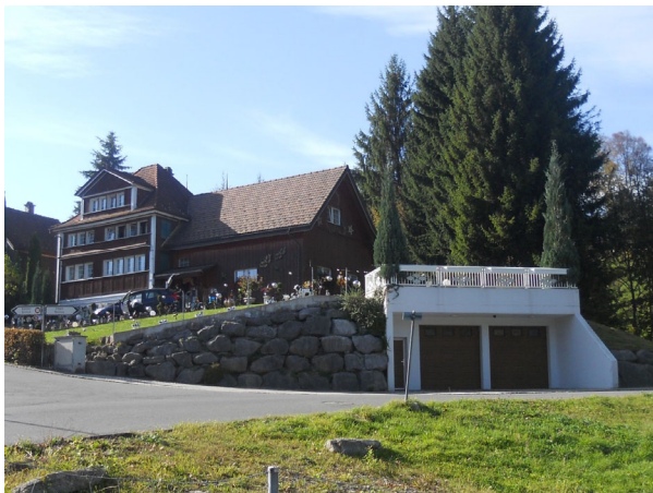
Umgebungsgestaltung mit Blocksteinmauer und Garage
