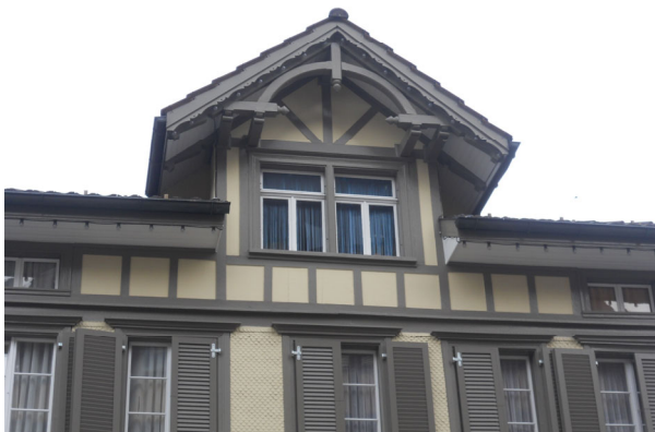
Quergiebel mit sichtbarem Gespärre
