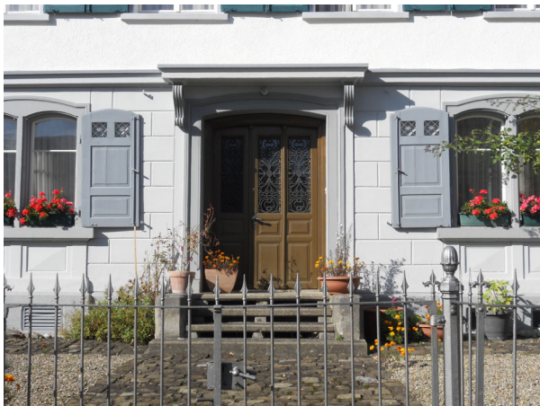
Zugangsportal mit offener Zugangstreppe (Steinplatten)
