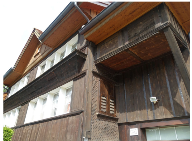
Fassadendetails Hauptfassade / östlicher Anbau
