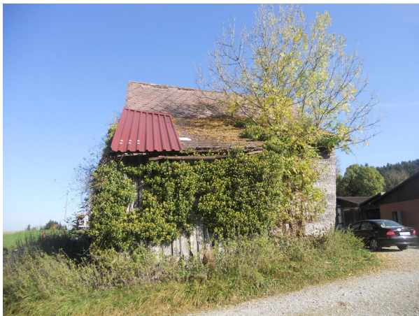
Ansicht von Westen mit provisorischer Dachsanierung
