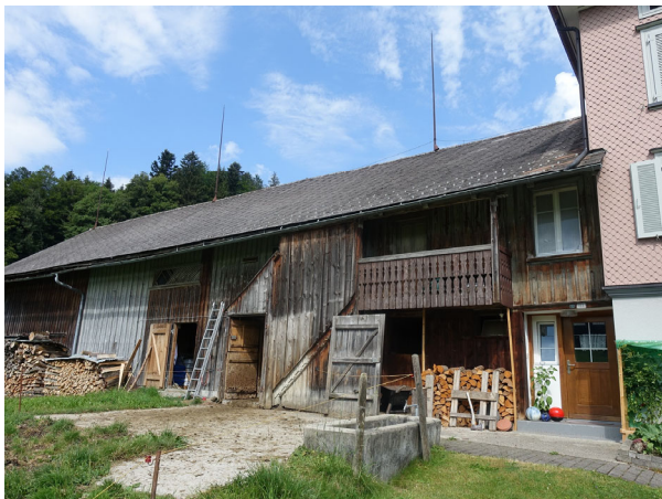
Ökonomiegebäude mit Laube
