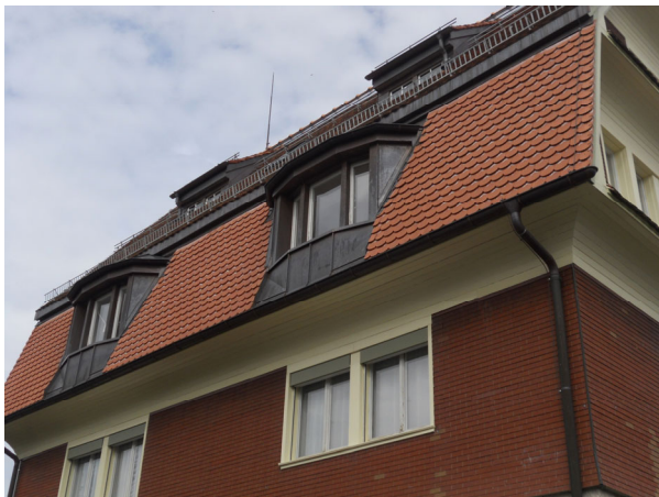
Polygonale ausgeformte Dachgauben an der Westfassade
