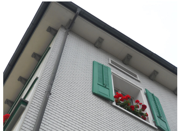
geschnitztes Gespärre unter geschlossener Traufe
