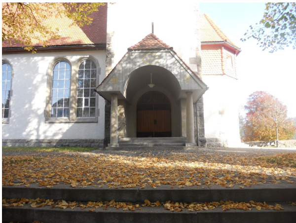
markanter Eingang auf der Westseite
