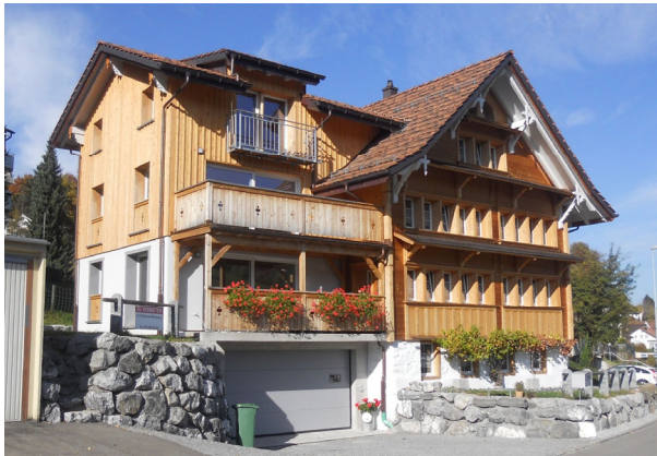
Garage, Balkone und grosse Fenster beim westseitigen Anbau
