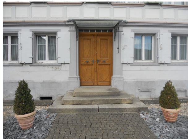
Eingangstüre mit dreistufigem Eingangspodest
