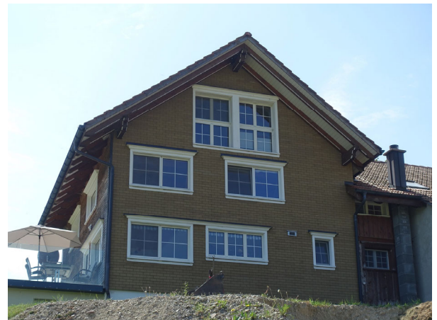
Neue Fenster an der Rückfassade
