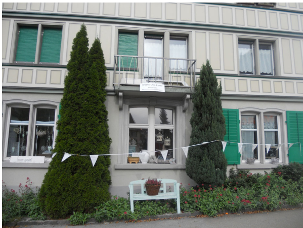
Hauptfassade mit Balkon über Sockel, ehem. Gebäudezugang
