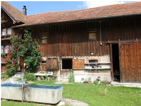
Mauerwerk und gezackter Leistenschirmabschluss bei Stall
