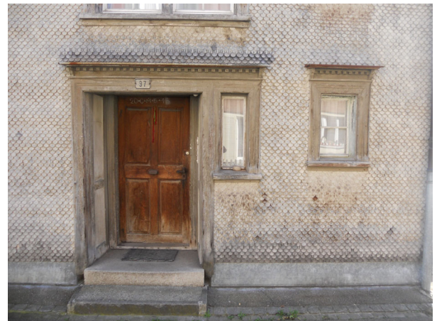
Rückseitiger Gebäudezugang im Anbau
