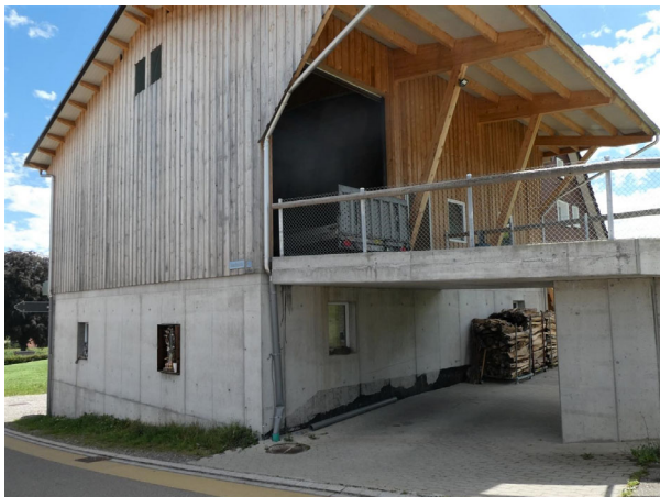
Rückseite Ökonomiegebäude mit Hocheinfahrt
