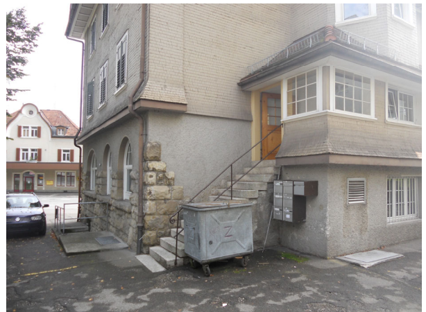
Zugang Obergeschosse auf der Rückseite
