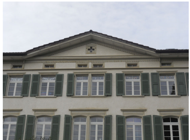
Quergiebel an der Hauptfassade
