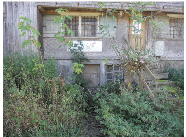
Haus und Kellerzugang auf der Strassenseite
