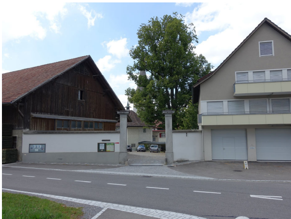
Eingang zur Äusseren Klausur; Gebäude Ass. Nr. 910 rechts
