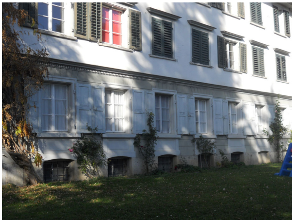
Sockelgeschossgestaltung mit Kellergeschossfenster
