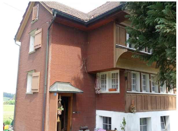
östlicher Anbau mit Eingangssituation
