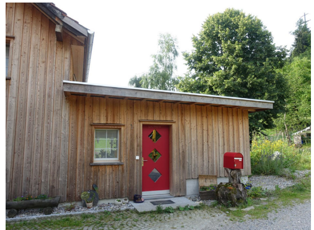
Hauszugang Anbau rückseitig
