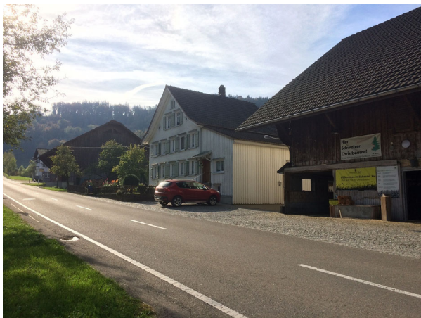
Ansicht im Strassenverlauf
