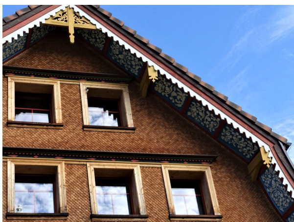
Details Giebelbereich Hauptfassade
