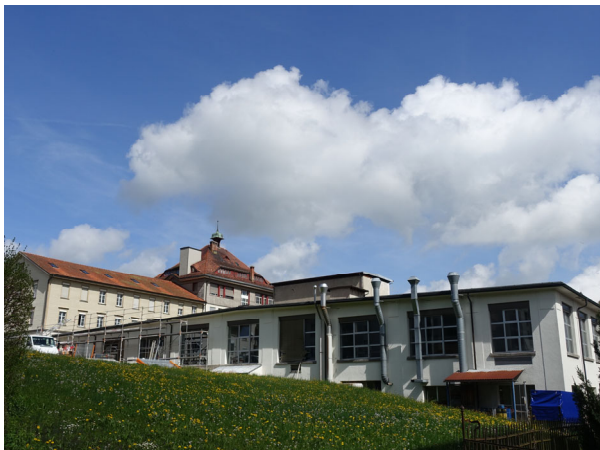
Eisenbetonsaal / Dachaufbau auf Zentralbau im Hintergrund
