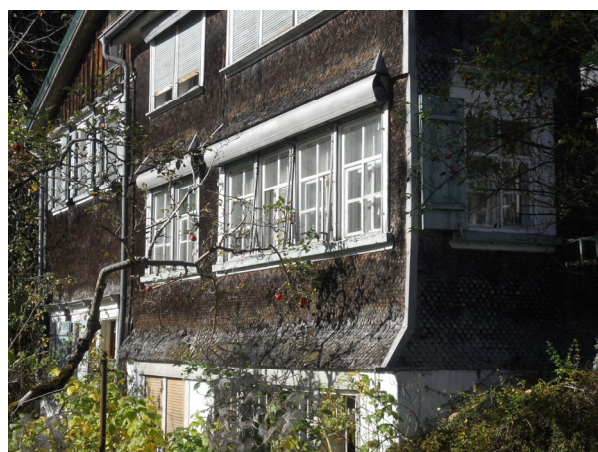
Fassade mit Abwürfen und Rollladenkästen
