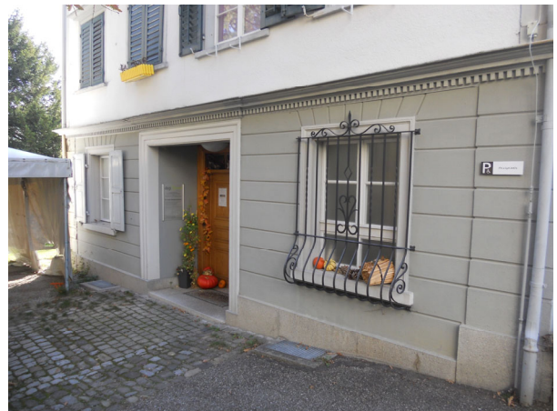
Osteingang und Fenster mit barockisierendem Fenstergitter
