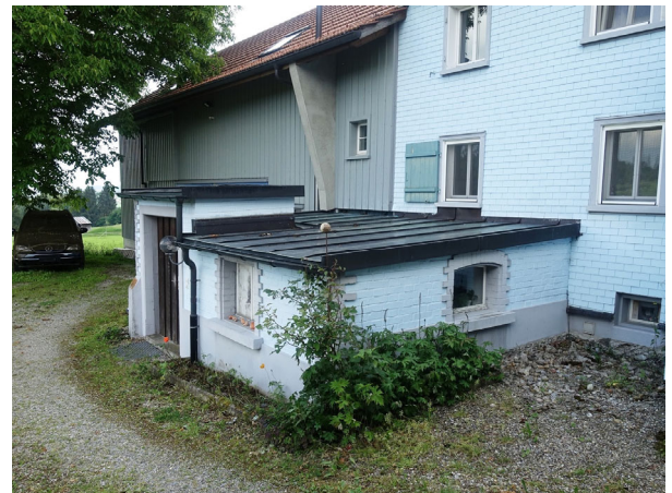
rückwärtige Fassade mit Mostereianbau
