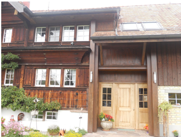
Übergang Haus - Stall mit neuem Hauszugang
