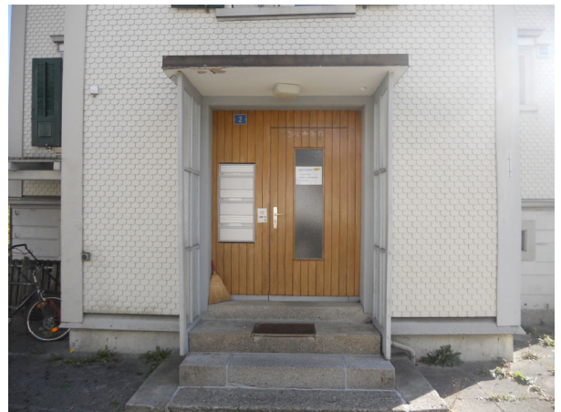
Gebäudezugang auf der Rückseite
