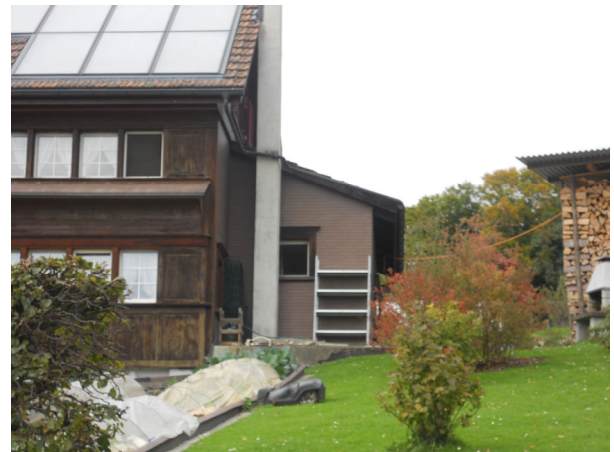
Ostseitiger Anbau mit Kamin und Sonnenkollektoren
