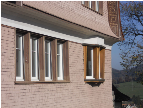
Erker an der Südfassade; bemalte Traufe
