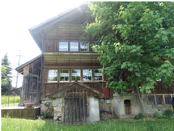
Kellerzugang und Sitzplatz
