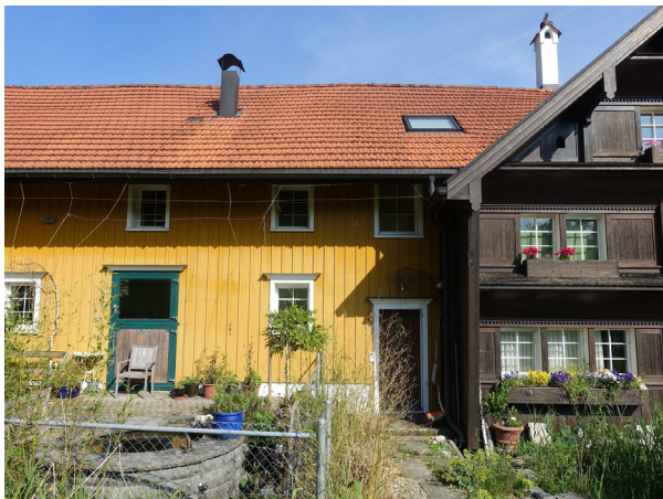
Übergang Wohnhaus - Stall mit ursprünglicher Eingangstüre
