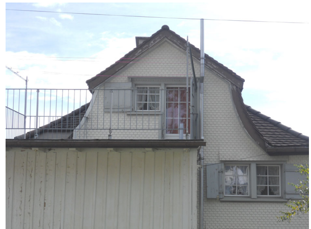
Abgeschnittenes Mansardendach beim Anbau
