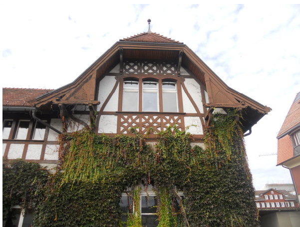
Giebfeldgestaltung mit Fachwerk, Gespärre und Ortgangbrett
