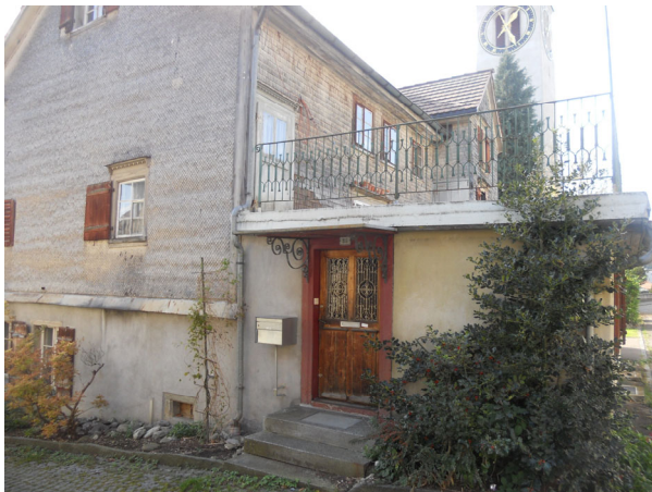
Rückseitiger Anbau mit separatem Eingang
