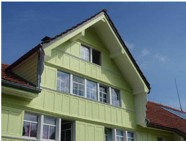
Kreuzgiebel mit den seitlichen Windbrettern
