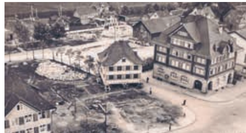
Das Haus Balmer musste 1934 dem heutigen Kantonalbankgebäude weichen und wurde an die Poststrasse verschoben.
