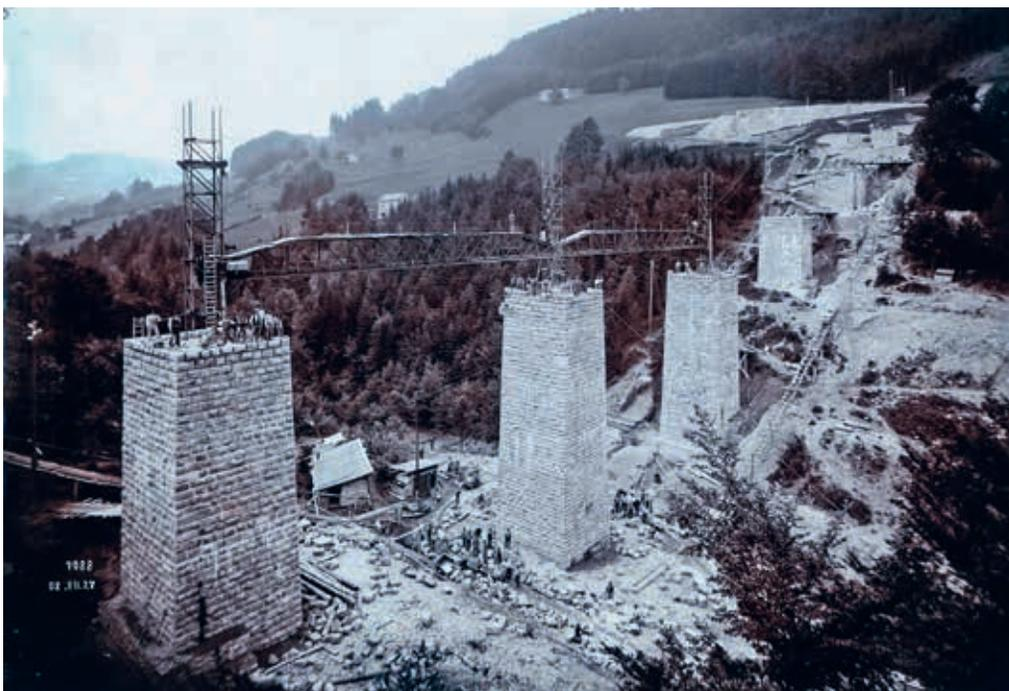
Die Brücke über das Wissbachtobel wurde grösstenteils mit reiner Menschenkraft errichtet.
