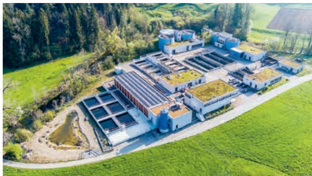
Die Kläranlage Oberglatt wurde für knapp 20 Millionen Franken erweitert. (Drohnenbild: Beat Schiltknecht)
