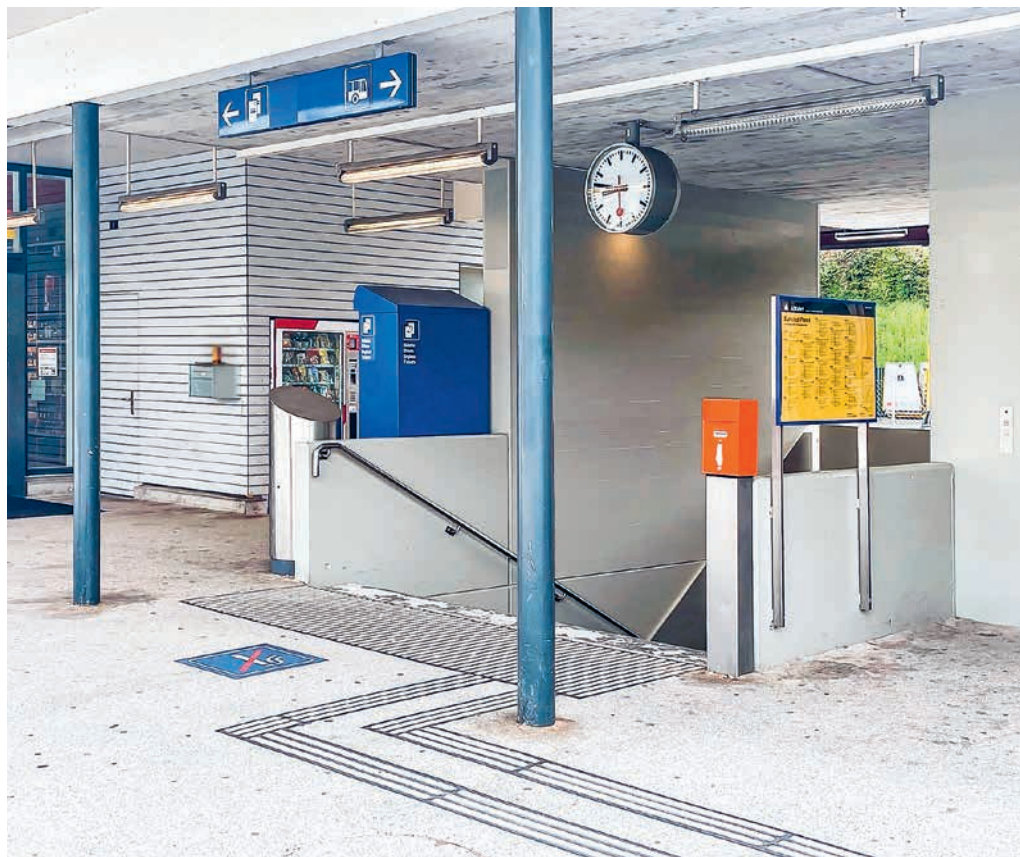
Beim Hauptabgang zu den Gleisen soll ein Notfallknopf installiert werden.
