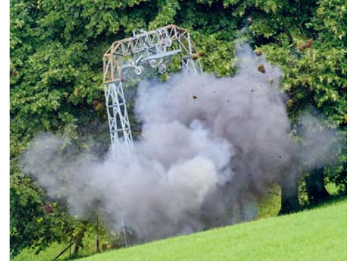
Am Montag, 23. August, wurden die Masten gesprengt.
