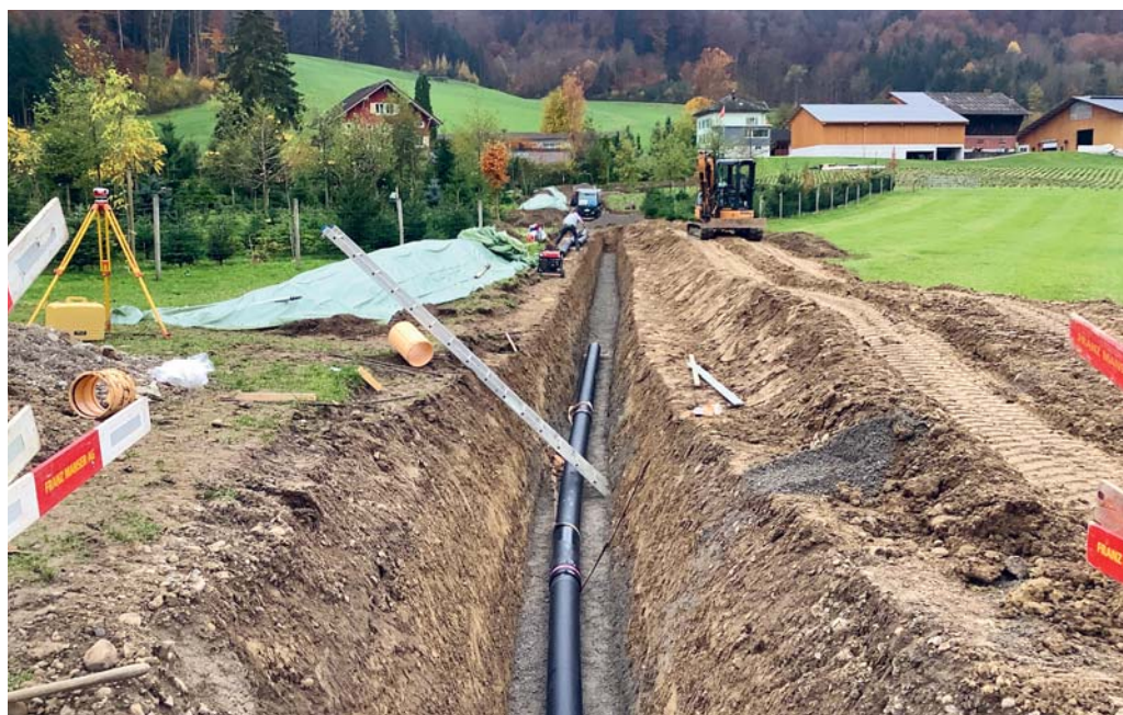
Das Abwassersanierungsprojekt Buebental ist abgeschlossen.
