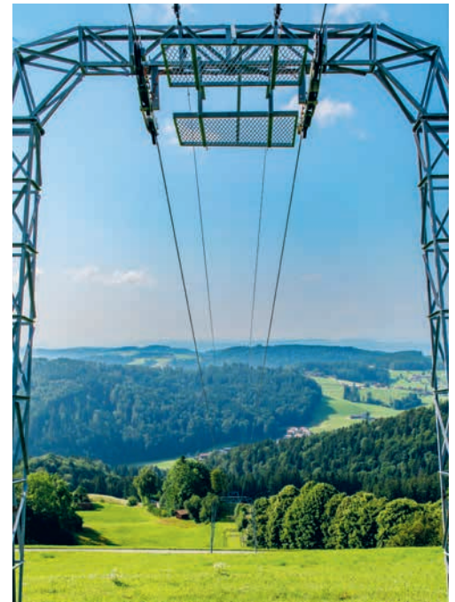
Die dritte Sektion des Skilifts Degersheim wird am 23. und 24. August 2021 durch die Armee zurückgebaut.
