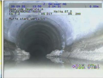
Bild 117 16,5 m Muffe stark verkalkt
