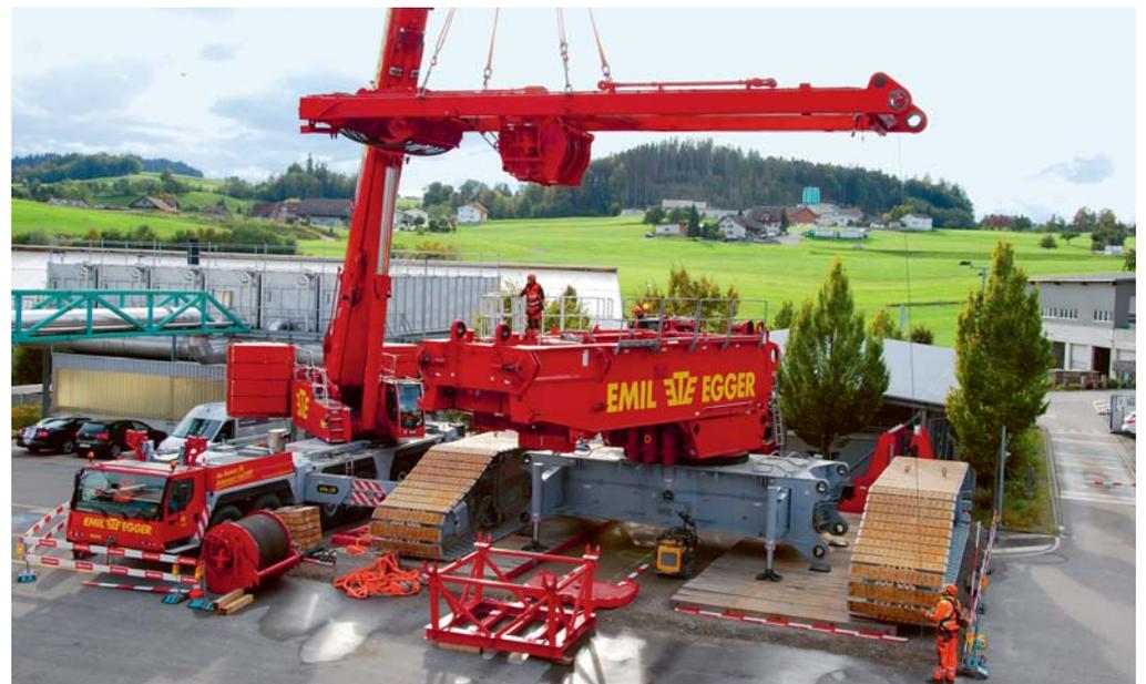
Das Fahrwerk für den über 80 Meter hohen 1000-Tonnen-Kran, welcher Ende November die neue Feuerung und den neuen Kessel ins Betriebsgebäude einhievt, steht in Bazenheid bereits vor Ort.
