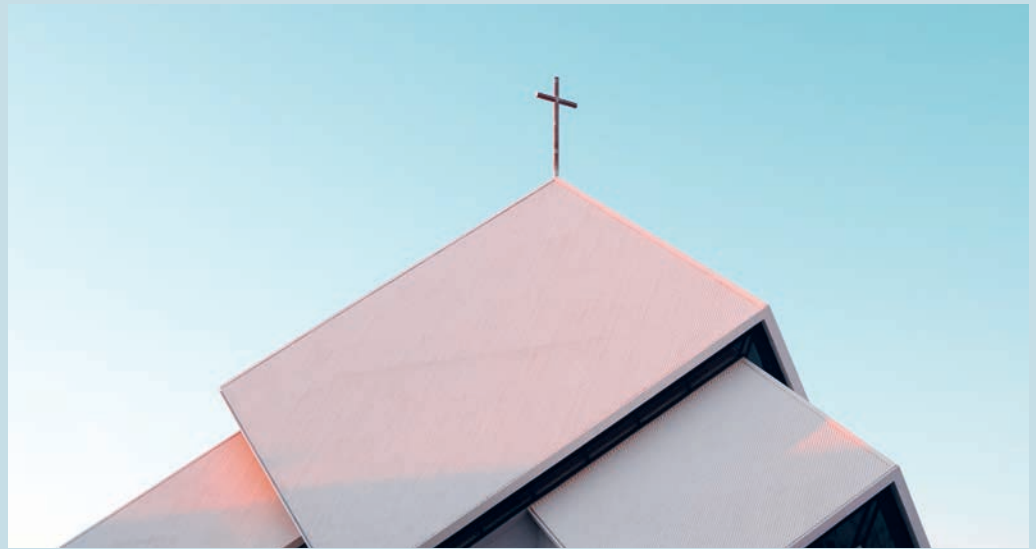
Während der Reformation lag Erneuerung in der Luft.
