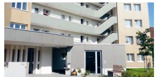
46 Prozent Energieersparnis dank Sanierung der Aussenhülle des Hauses Feld.
