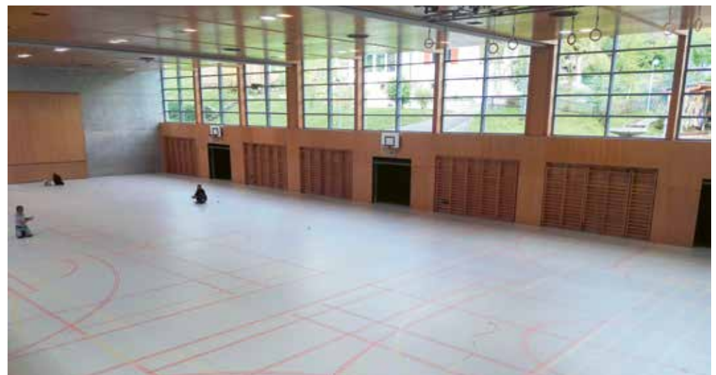
Der Hallenboden der Dreifachturnhalle Steinegg wurde während der Herbstferien saniert.
