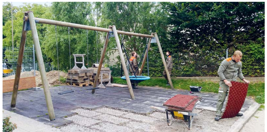
Auch bei der Neugestaltung des Pausenplatzes Enzenbühl leistet der Zivilschutz die Vorbereitungsarbeiten.
