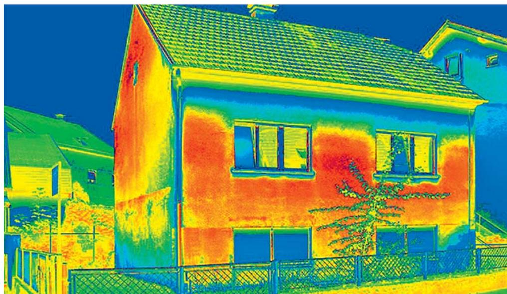
Die Thermografie bringt die Schwachstellen eines Gebäudes ans Licht. Bei den roten Stellen sind die Wärmeverluste am grössten.
