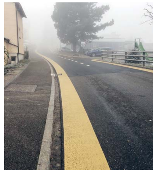
Die gelben Streifen entlang der Taa- und der Fuchsackerstrasse erhöhen die Verkehrssicherheit.
