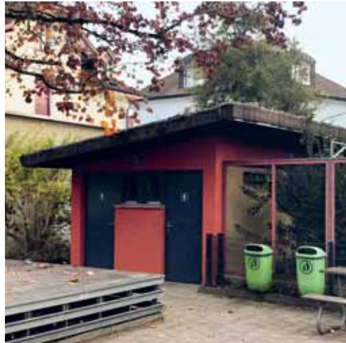
Beim Vögelipark entsteht bis Ende Januar 2019 eine neue WC-Anlage.
