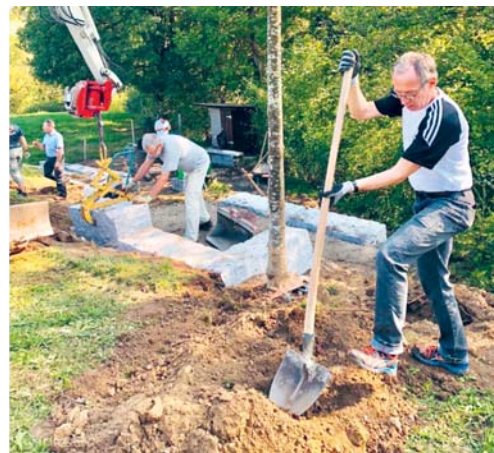
Mit Bagger und Schaufel wurden die Sitzbänke und ein Schatten spendender Baum gesetzt.
