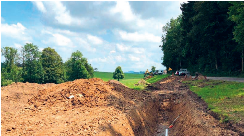
Die Verlegung der Leitung steht kurz vor dem Abschluss.
