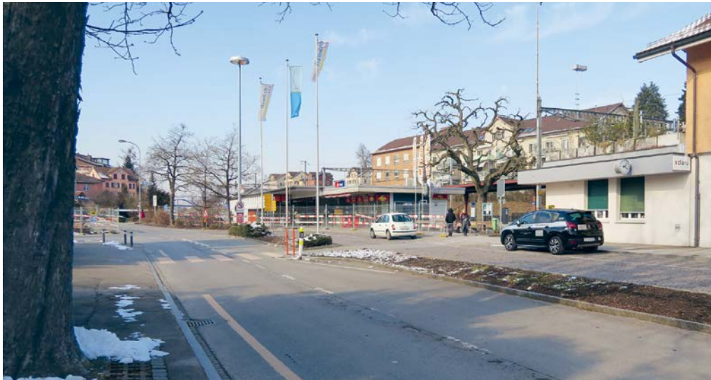
Die Bauarbeiten für die erste Phase der Gesamterneuerung des Bahnhofplatzes beginnen am 3. April 2018.
