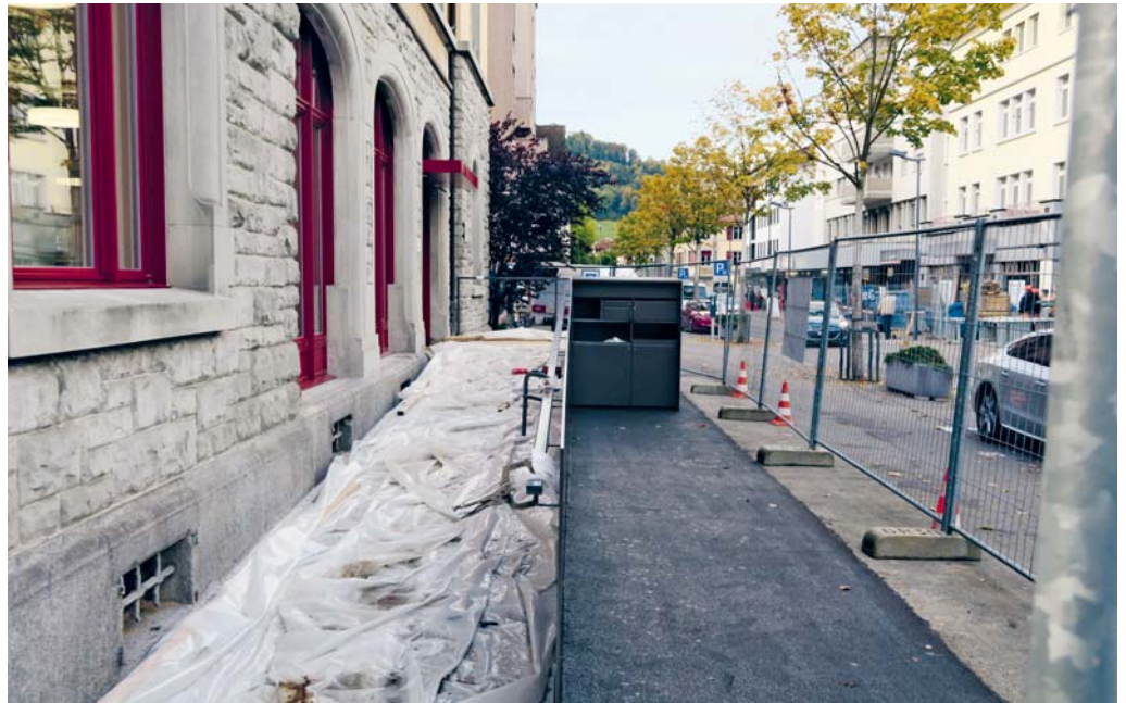
Eine der letzten Arbeiten: Die Fertigstellung des behindertengerechten Zugangs.
