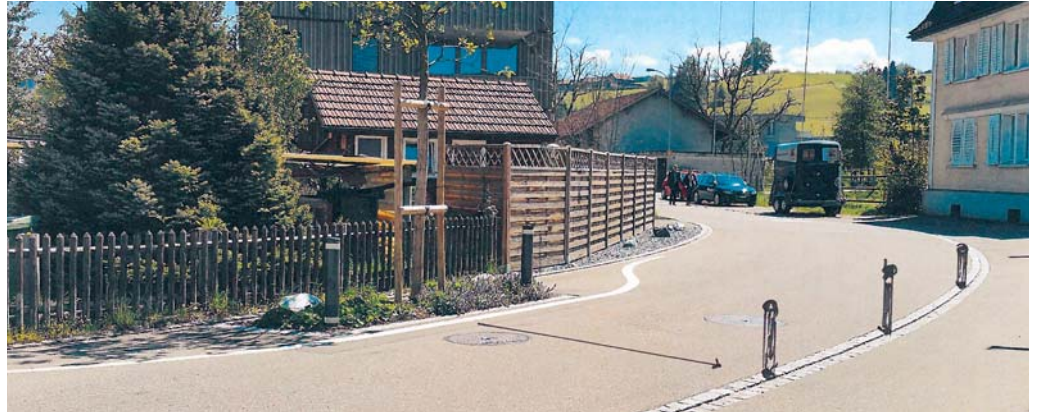
Visualisierung: Im Bereich der Baumgrube werden an dieser Stelle drei Leitpfosten installiert.
