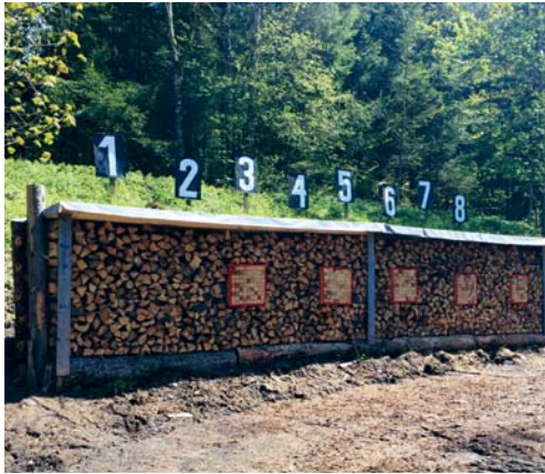
Bei der Instandstellung des Kugelfangs bei der Schiessanlage Giren war der Zivilschutz behilflich.
