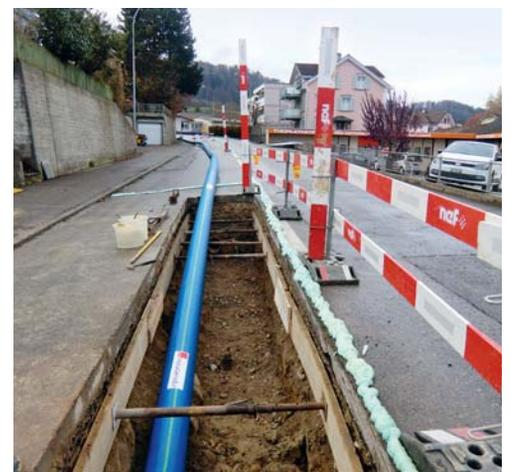
Das neue, 180 Meter lange Rohr wird eingezogen.
