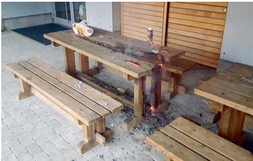
Der brennende Aussen-Holztisch wurde von Mitarbeitenden des Unterhaltsdienstes entdeckt.
