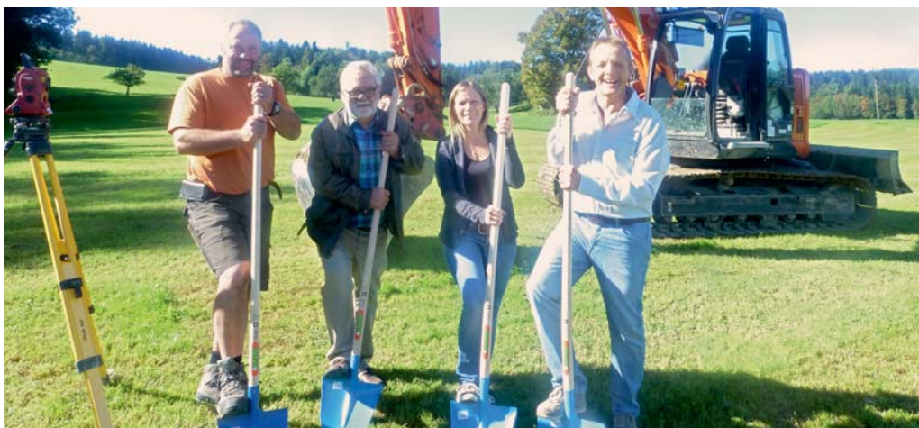
V.l.n.r.: Meinrad Schilliger, Schilliger Bagger und Lohnunternehmung, und Christian Eisenhut, Architekturbüro Eisenhut & Partner, freuen sich mit Andrea und Christian Tschumper als Bauherrschaft über den ersten Spatenstich.
