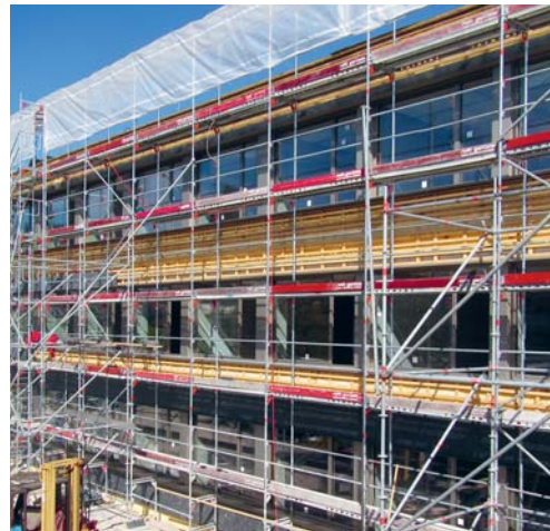
Die Fassade nimmt Gestalt an.
