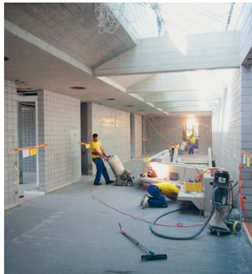
Die Handwerker arbeiten auf Hochtouren, um das Oberstufenschulhaus bis zum Einzugstermin fertigzustellen.
