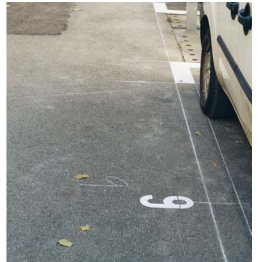
Derzeit werden die Parkplätze markiert.
