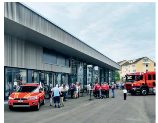
Nach der Einweihung konnte die Bevölkerung das neue Feuerwehrdepot besichtigen.
