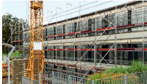
Der Klassentrakt wird in der ersten Etappe saniert.
