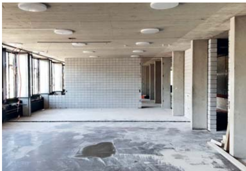
Die neuen Fenster sind montiert.
