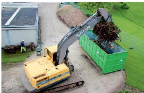
Die Vorbereitungen für die Sanierung des Oberstufenschulhauses sind gestartet.
