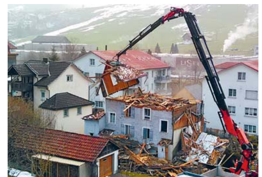
Das alte Haus wurde abgebrochen, damit neuer Platz entsteht für einen Ersatzbau mit drei Eigentumswohnungen. (Bild: Eugen Cozzio)
