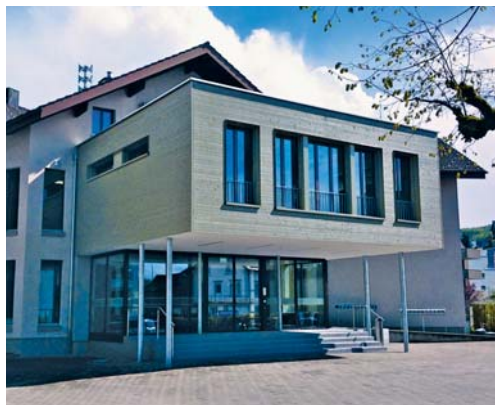
Der neue Eingangsbereich mit dem angebauten Teamzimmer.
