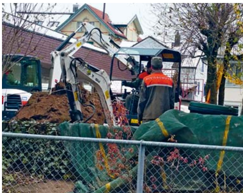
Die Zivilschützer bei den Erd- und Vorbereitungsarbeiten.
