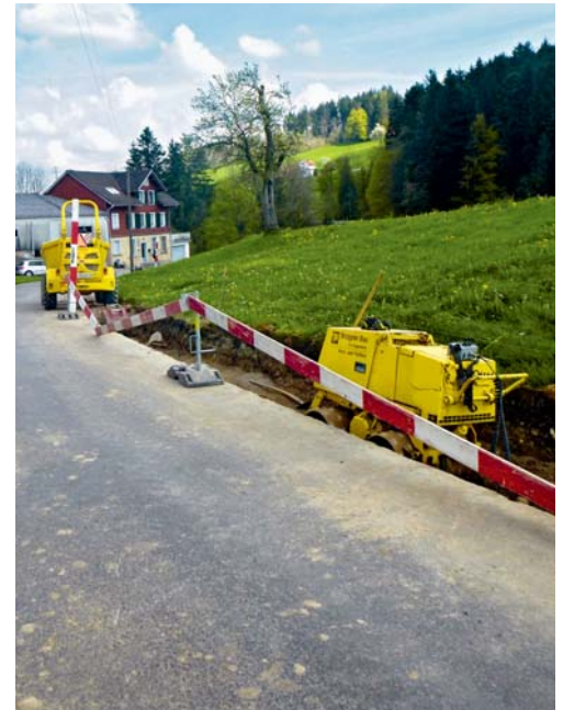
Die Bühlstrasse wird dieses Jahr in der dritten Etappe umfassend saniert.
