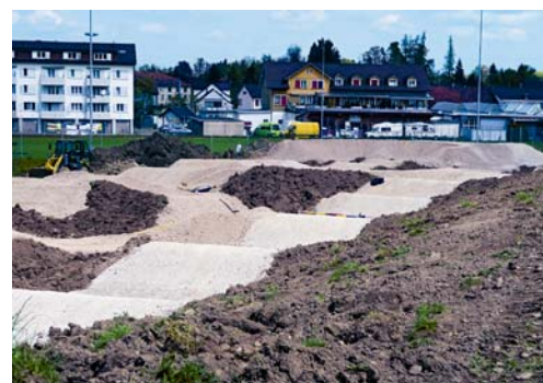
In wenigen Tagen ist die Pumptrack-Anlage fertiggestellt.
