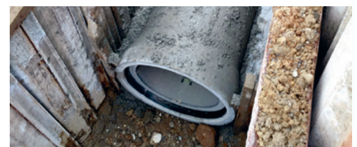
Die Sanierungsarbeiten an der Enzenbühlstrasse werden fortgesetzt.
