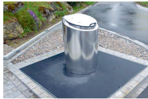
Der erste Unterflurbehälter der Gemeinde Degersheim wurde in Betrieb genommen.
