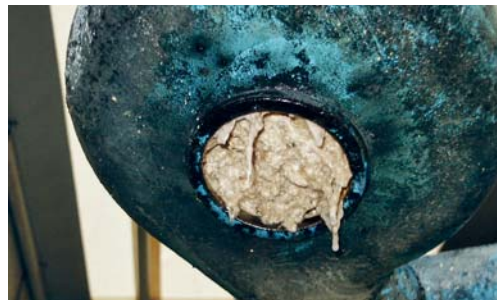
Verstopfte Abwasserpumpanlage
