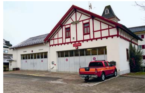
Das 100-jährige Feuerwehrdepot soll abgebrochen werden. Eine Zwischennutzung als Kulturraum ist möglich.
