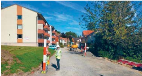
An der Hörenstrasse wurden umfangreiche Sanierungsarbeiten vorgenommen.
