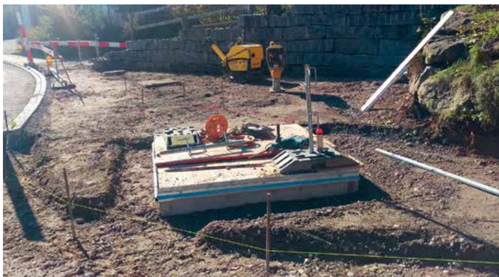
Die Bauarbeiten an der Kreuzung Freudenberg-, Hörenstrasse, Blumenweg haben auch den Einbau eines Unterflurbehälters umfasst.
