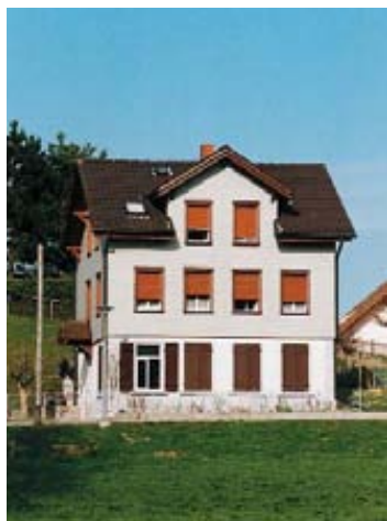
3 Typisches Stickerhaus in Wolfertswil, erbaut um 1896. Auffallend sind die hohen Fenster im Erdgeschoss. Der Hand- stickmaschinenraum musste eine Höhe von rund drei Metern haben.
