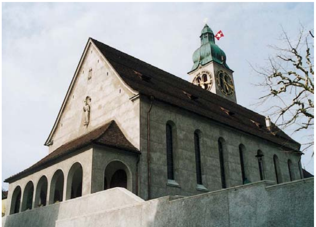
13 Die restaurierte St.Jakobuskirche: ein nüchternes Äusseres mit der markanten Zwie- belkuppel.
