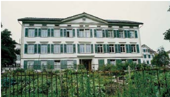
Schulhaus Bergstrasse, seit 1957 Kindergarten. Erbaut 1866 als evan- gelisches Primarschulhaus. Von 1905 bis 1973 Sekundar- schulhaus.
