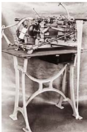
17 Fädemaschine, System Saurer. Für viele Sticker war der Ankauf der Fädemaschine zu teuer. So verrichteten weiterhin Frau und Kinder die Arbeit von Hand.
