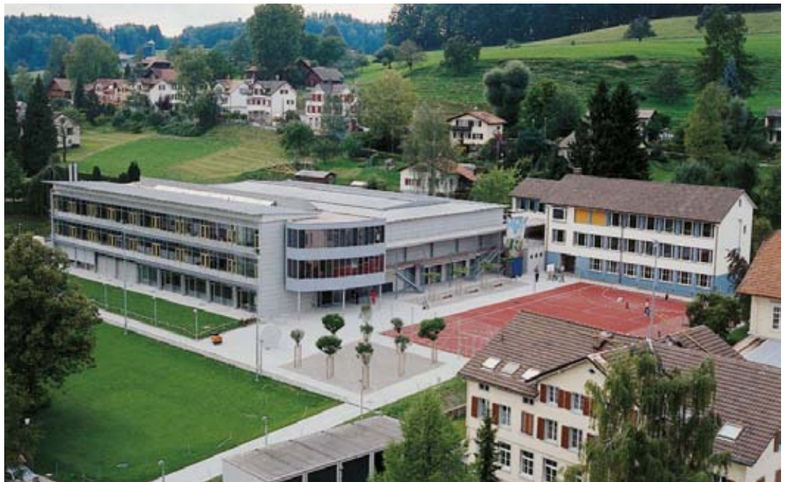
17 Im September 1996 eingeweiht: Schul- und Mehrzweckanlage Steinegg.
