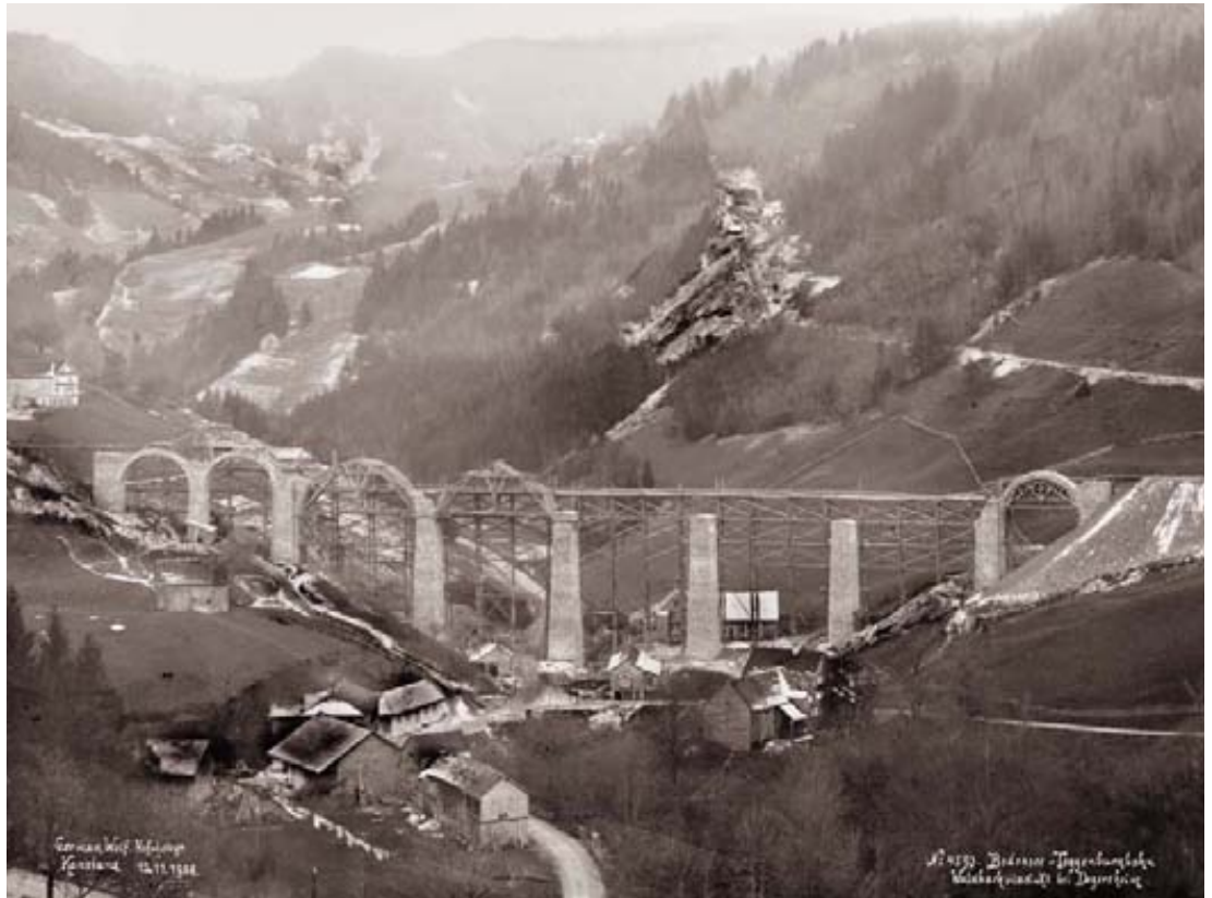
Bau Waldbach-Viadukt bei Degersheim, 1908. Oben rechts ist ein Steinbruch für den Brückenbau erkennbar.
