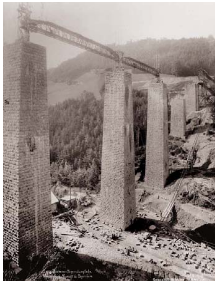
1 Bau Wissenbach-Viadukt bei Degersheim für die BT, 1908.
