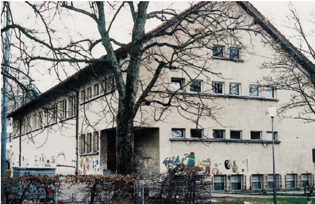
12 Nach 50jährigem Ringen wurde 1940 endlich eine Turnhalle gebaut. Unser Bild: die Halle kurz vor dem Abbruch im Frühling 1996.
