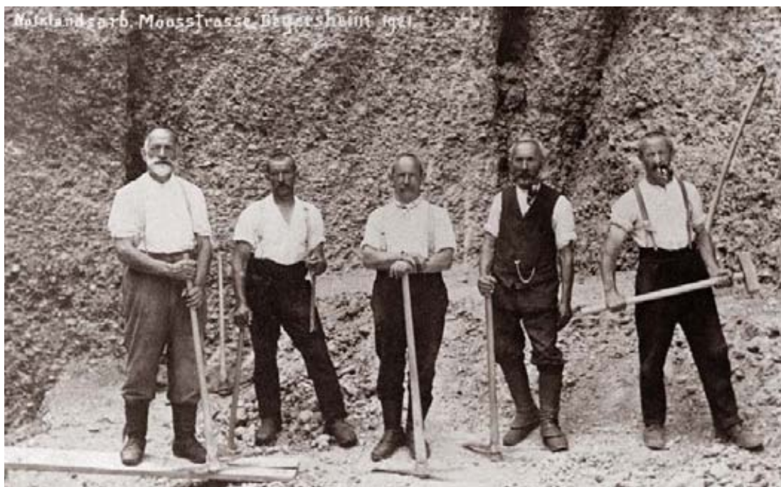
8 Nach dem Ersten Weltkrieg herrschte in ganz Europa Arbeitslosigkeit. Um die Not zu lindern, wurden «Notstandsarbeiten» ausgeführt. Unser Bild von 1921: Arbeiter beim Bau der Moosstrasse.
